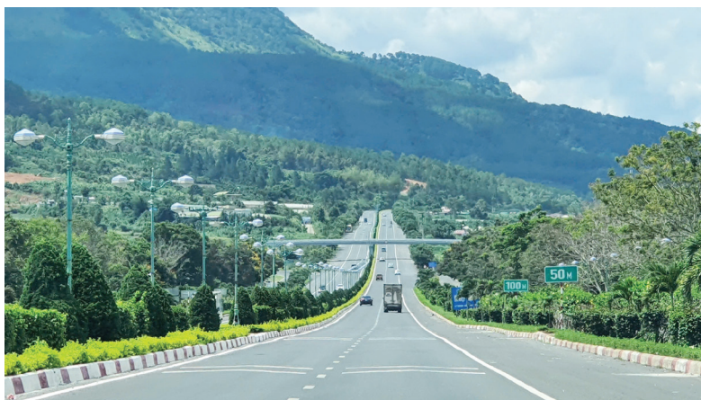
Cao tốc Liên Khương - Prenn được lắp đặt hệ thống camera giao thông để quản lý trật tự an toàn giao thông.
