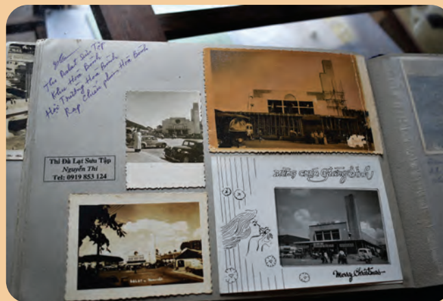
Hình ảnh khu Hòa Bình qua từng giai đoạn.
